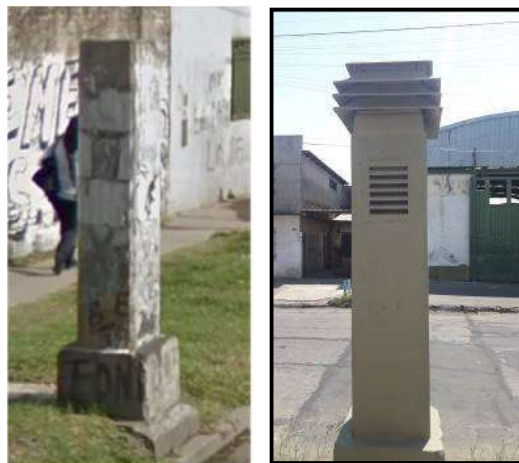
Columna de ventilación Cámara de Acceso N°19
