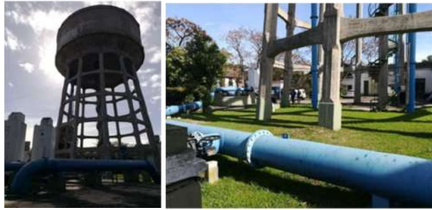
Cisterna y tanque de Acassuso para futuro banco de calibración
