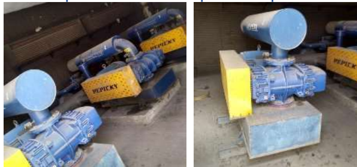
Soplantes lobulares de desplazamiento positivo
