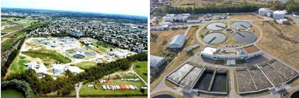
Vista aérea del Módulo I y II de la Planta Depuradora Norte
