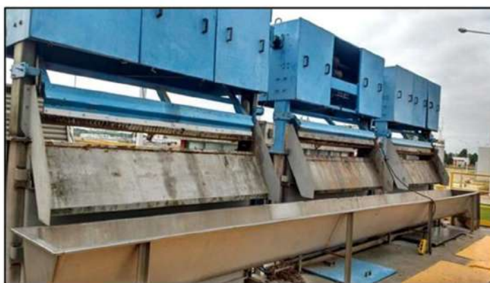
Rejas de ingreso a Planta
