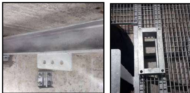
Estructura de izaje
