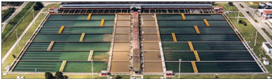
Vista aérea de los decantadores de Planta
