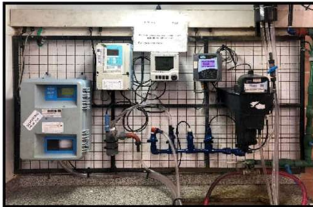
Readecuación SMCC EE Devoto
