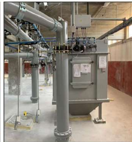
Filtro colector de polvo
