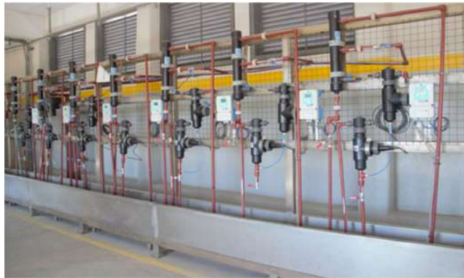
Readecuación SMCC filtrada PJMR
