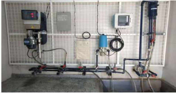
Readecuaciones SMCC cruda + coagulante A1 PSM
