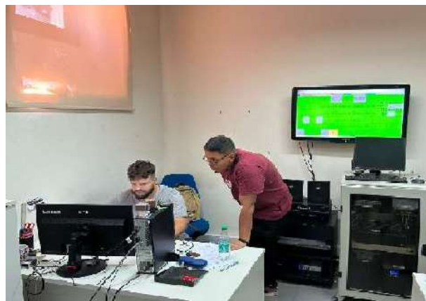
Vista del Control Centralizado
