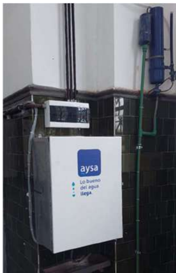
Readecuación SMCC Ensachetadora
