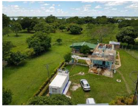
Vista panorámica de la Planta Potabilizadora de Itatí con la EM01TC
