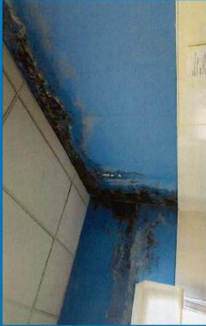
Relevamiento con fecha del 26/05/2017. Se verificó que hay humedad en las paredes del laboratorio de análisis clínico; según lo informado por los facultativos, dicha situación imposibilita el trabajo con los equipos de alta complejidad, debido a que se contaminan las muestras
