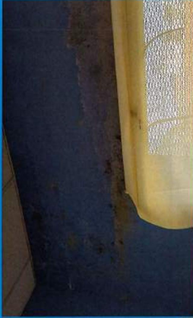
Relevamiento con fecha del 26/05/2017. Se verificó que hay humedad en las paredes del laboratorio de análisis clínico; según lo informado por los facultativos, dicha situación imposibilita el trabajo con los equipos de alta complejidad, debido a que se contaminan las muestras
