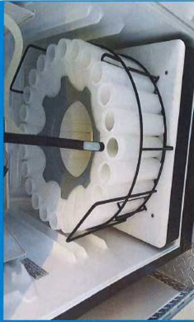
Vista del interior: Sistema de Captura de toma de muestras automático marca Hach SIGMA SD 900 Fecha de relevamiento: 4/08/2017
