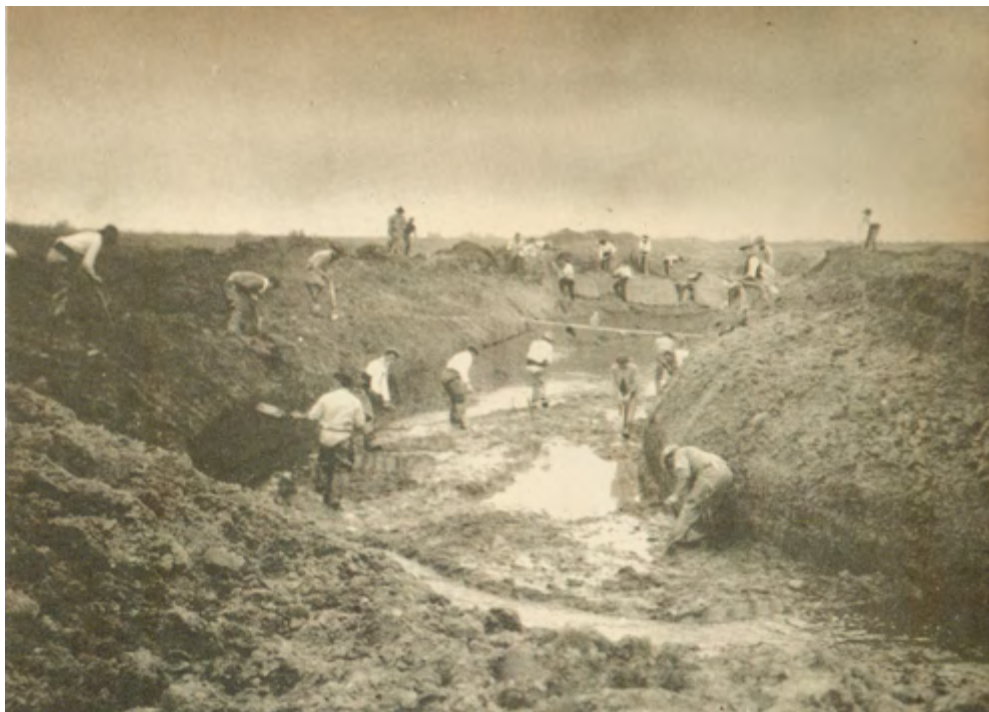
OBRAS DE CANALIZACIÓN DEL ARROYO MORÓN, 1937. FUENTE: ARCHIVO HISTÓRICO DE MORÓN
