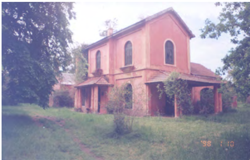
» ESTANCIA LA RECOLETA. CONSTRUCCIÓN DEL PERÍODO COLONIAL. FUENTE: JUNTA DE ESTUDIOS HISTÓRICOS DE LA MATANZA.
